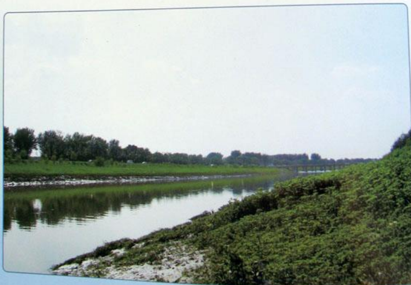
张家湾坑塘蓄水工程
