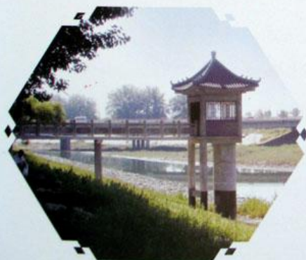
通州站自记水位井
