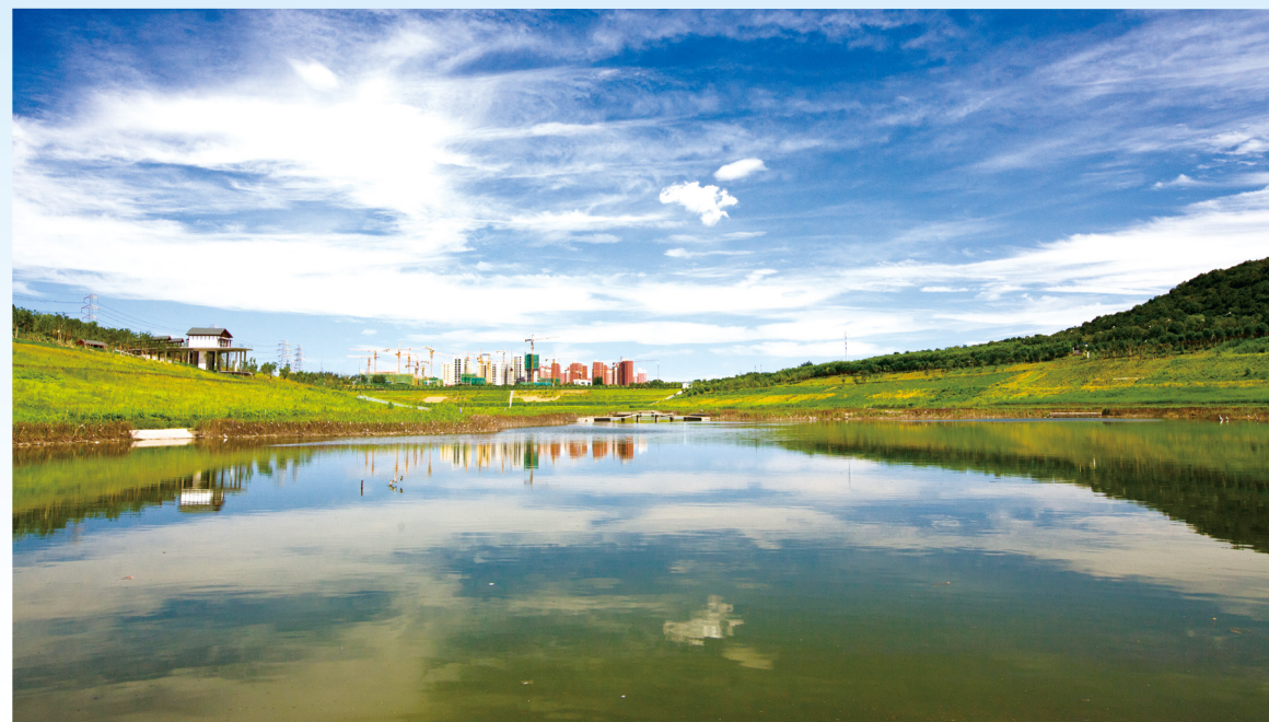
北京市西郊雨洪调蓄工程
