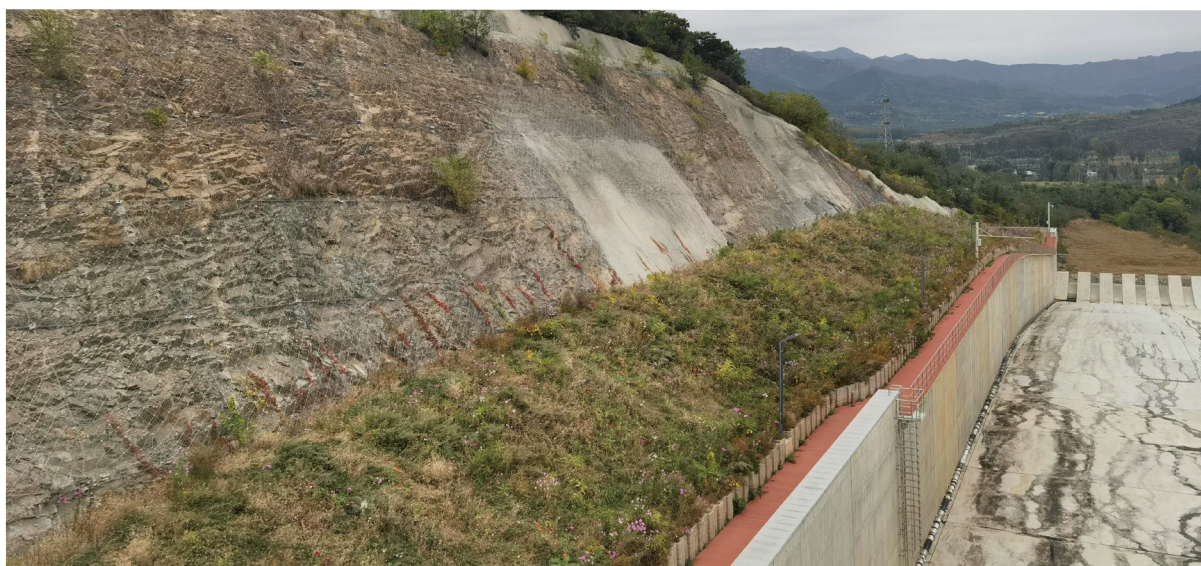
密云水库第一溢洪道改建工程(水土保持措施实施后)
