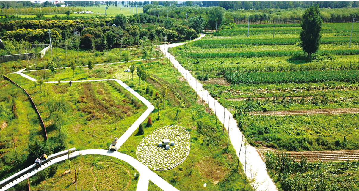
房山区高庄生态清洁小流域(局部)
