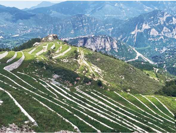
房山区西苑小流域梯田整修
