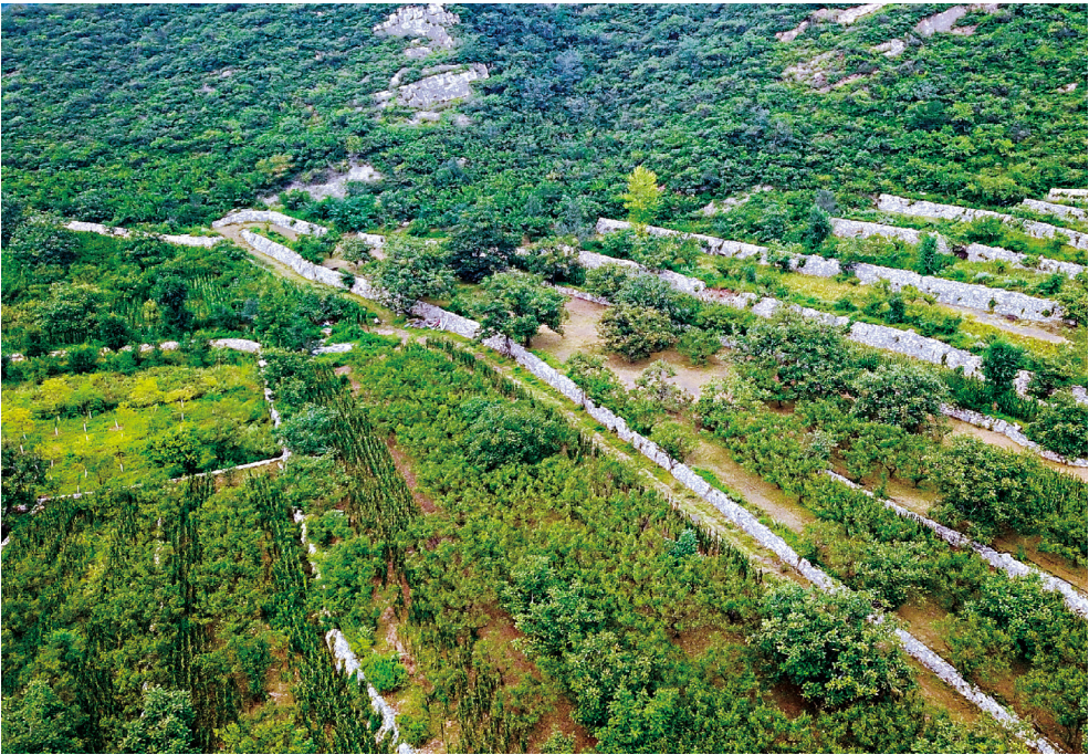
昌平区老峪沟小流域梯田整修
