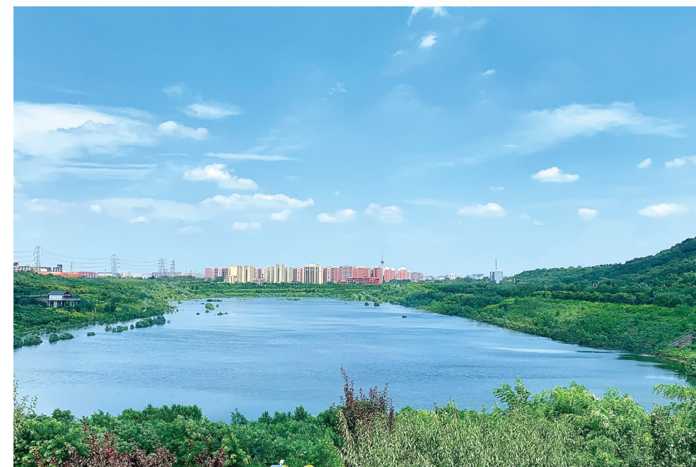
北京市西郊雨洪调蓄工程
