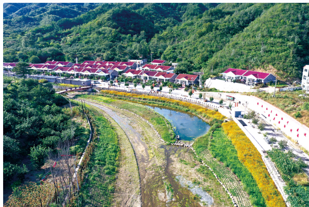
密云区古石峪小流域沟道治理
