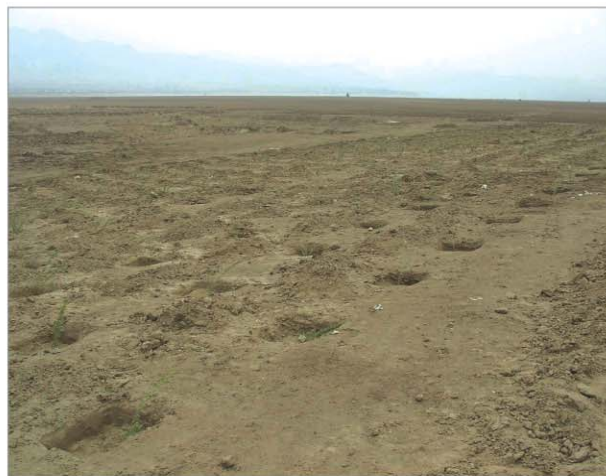
项目区施工中
