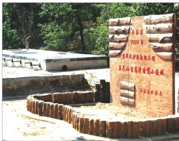
平谷区鱼子山小型污水处理设施
