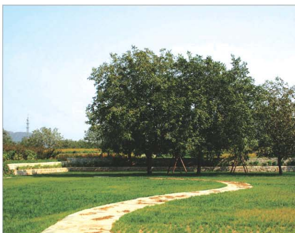
密云县石蛾小流域护地坝工程
