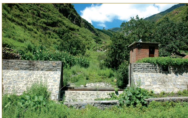
房山区西泥洼沟道控制站
