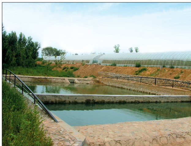
延庆县大浮坨小流域蓄水池
