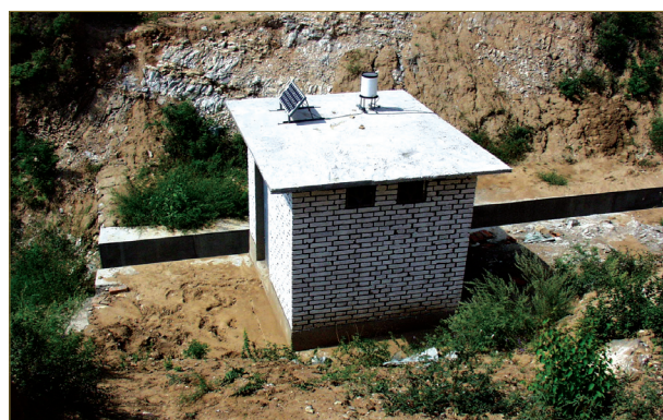
延庆县上辛庄北沟沟道控制站
