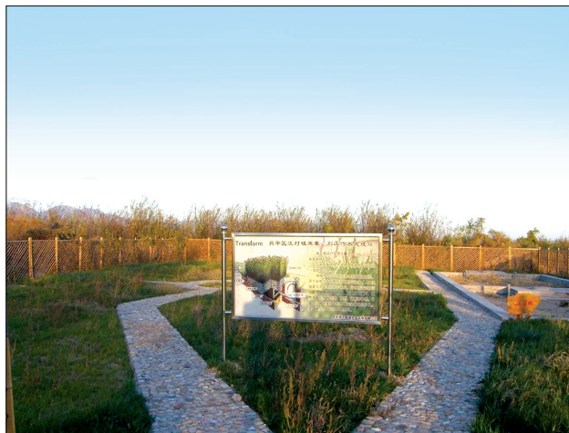
昌平区新建小流域小型污水处理设施
