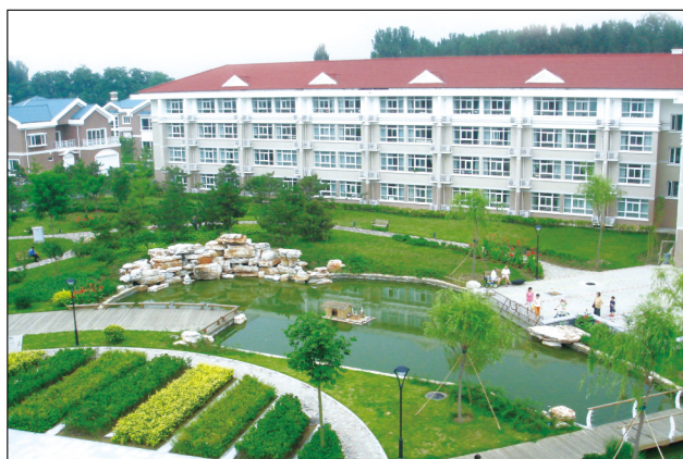
昌平区老年社区水土保持措施
