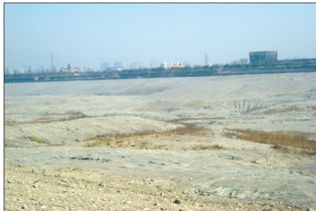
项目区施工中
