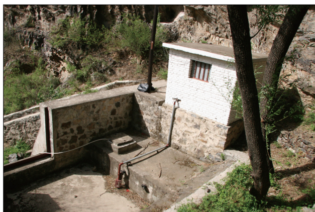
房山区下道峪沟道控制站
