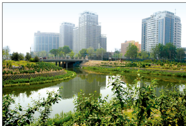
城市河道亮马河整治中水土保持措施
