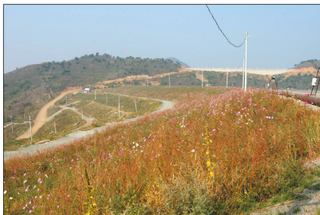
密云县铁矿建设项目边坡恢复治理
