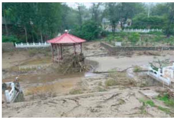
房山区云居寺小流域沟道冲淤积
