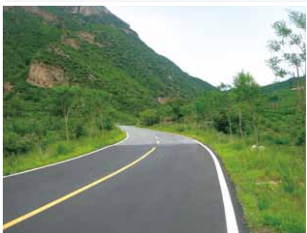
门头沟区双大路一期项目水土保持措施
