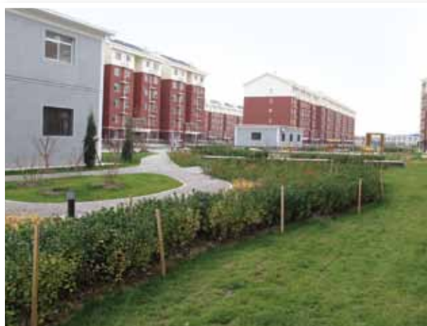
昌平区大型回迁楼项目水土保持措施
