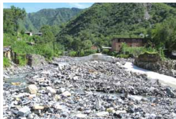
房山区南窖小流域沟道冲淤
