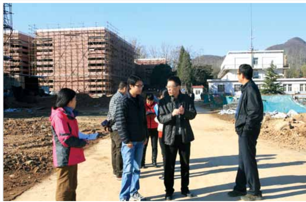
市水务局现场检查中科院研究生院新园区项目水土保持工作
