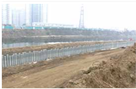
项目区施工中
