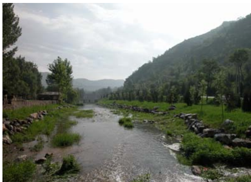
怀柔区神堂峪清洁小流域
