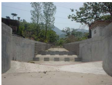
怀柔张台子沟道控制站
