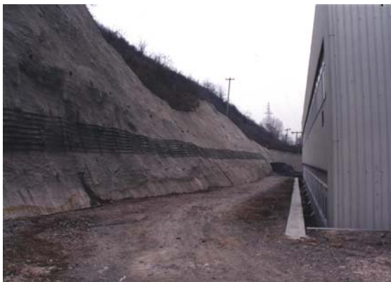
京煤集团技改项目水土保持工程
