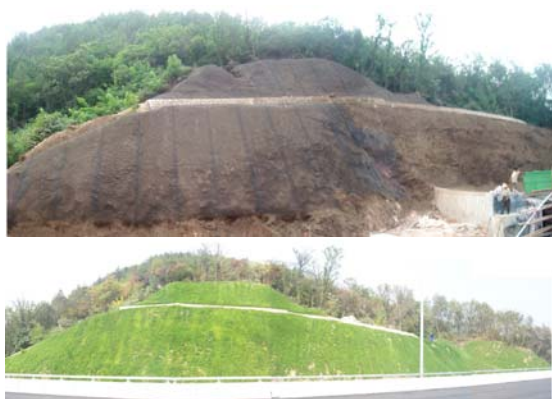
五环路红山口水土保持工程施工前后
