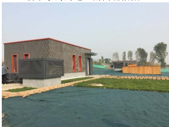
节制闸及地埋式泵站
