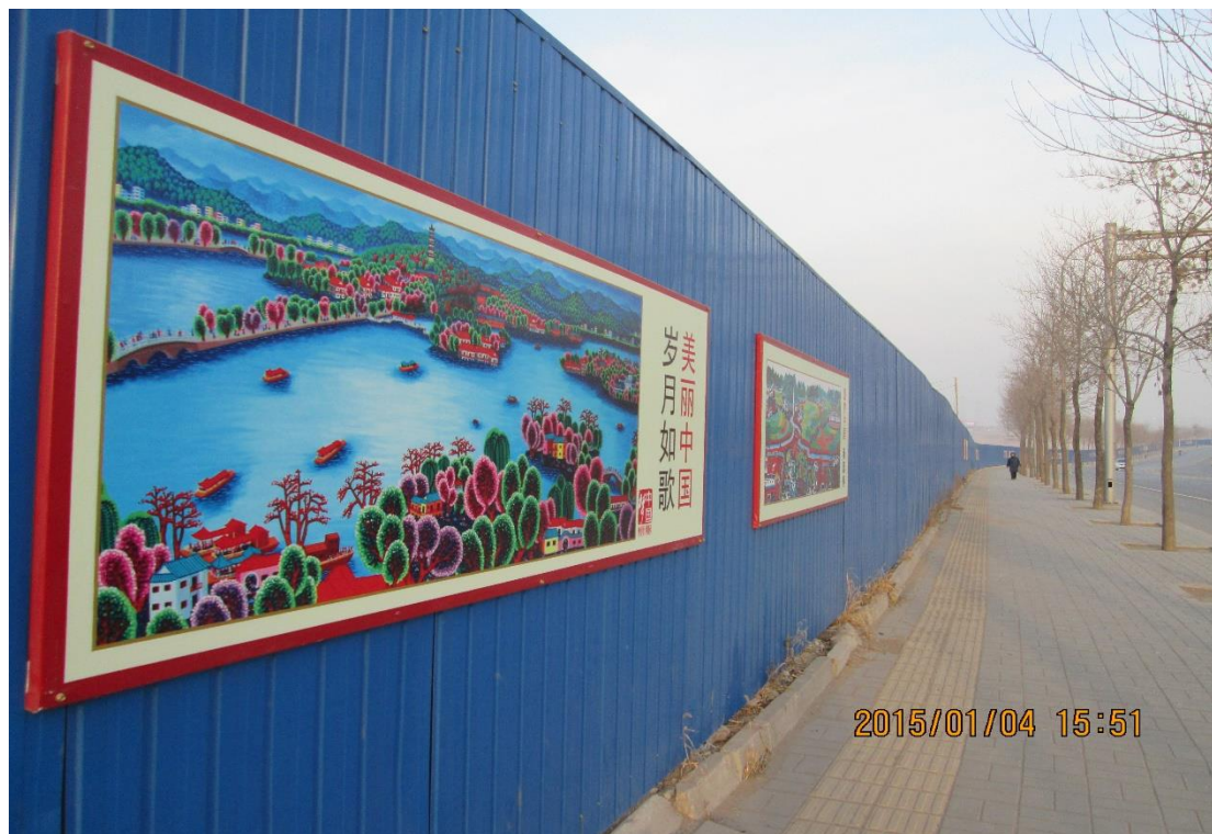
施工场地外全部围挡
