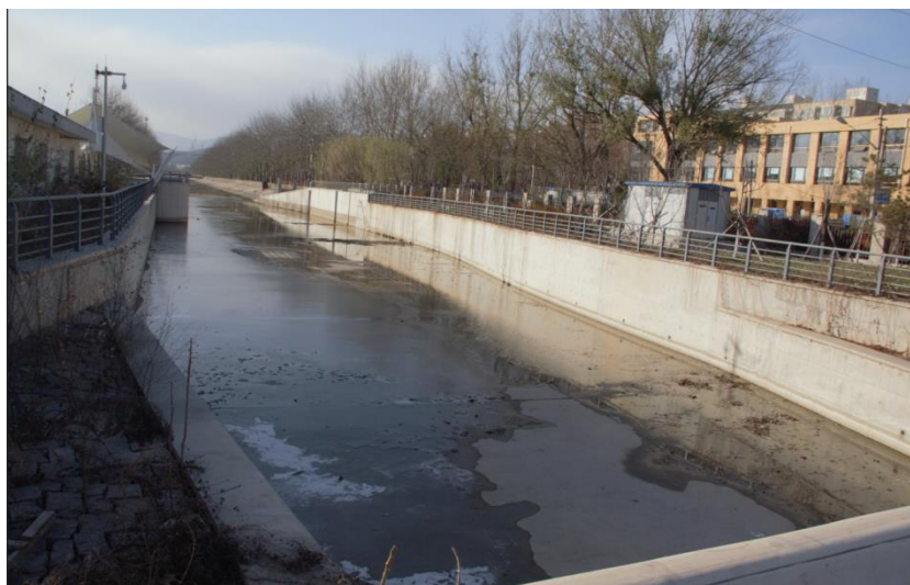
图 8.2-1 非汛期的永引渠（分洪闸段渠道）
