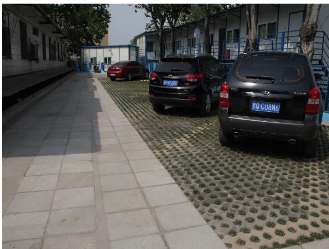
西黄村砂石坑施工生活区恢复情况
