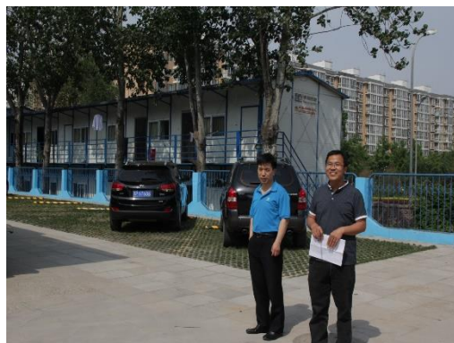
西黄村砂石坑施工营地区域（2018 年 5 月）
