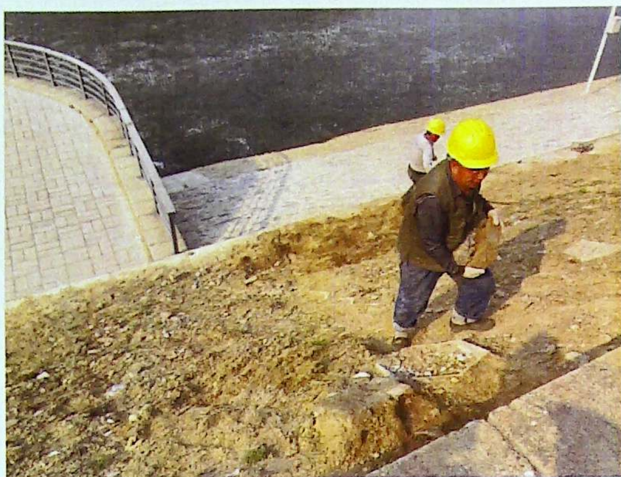
坡岸损坏的实心六棱砖更换工作正在施工
