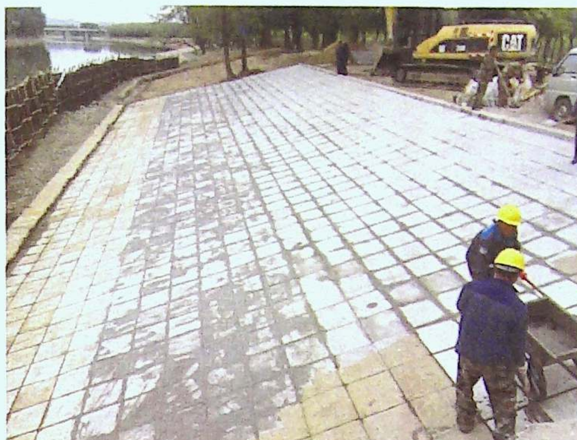
清除破损的实心六棱砖护岸，改为空心六棱砖 修复鲁疃闸破损的浆砌石护坡
