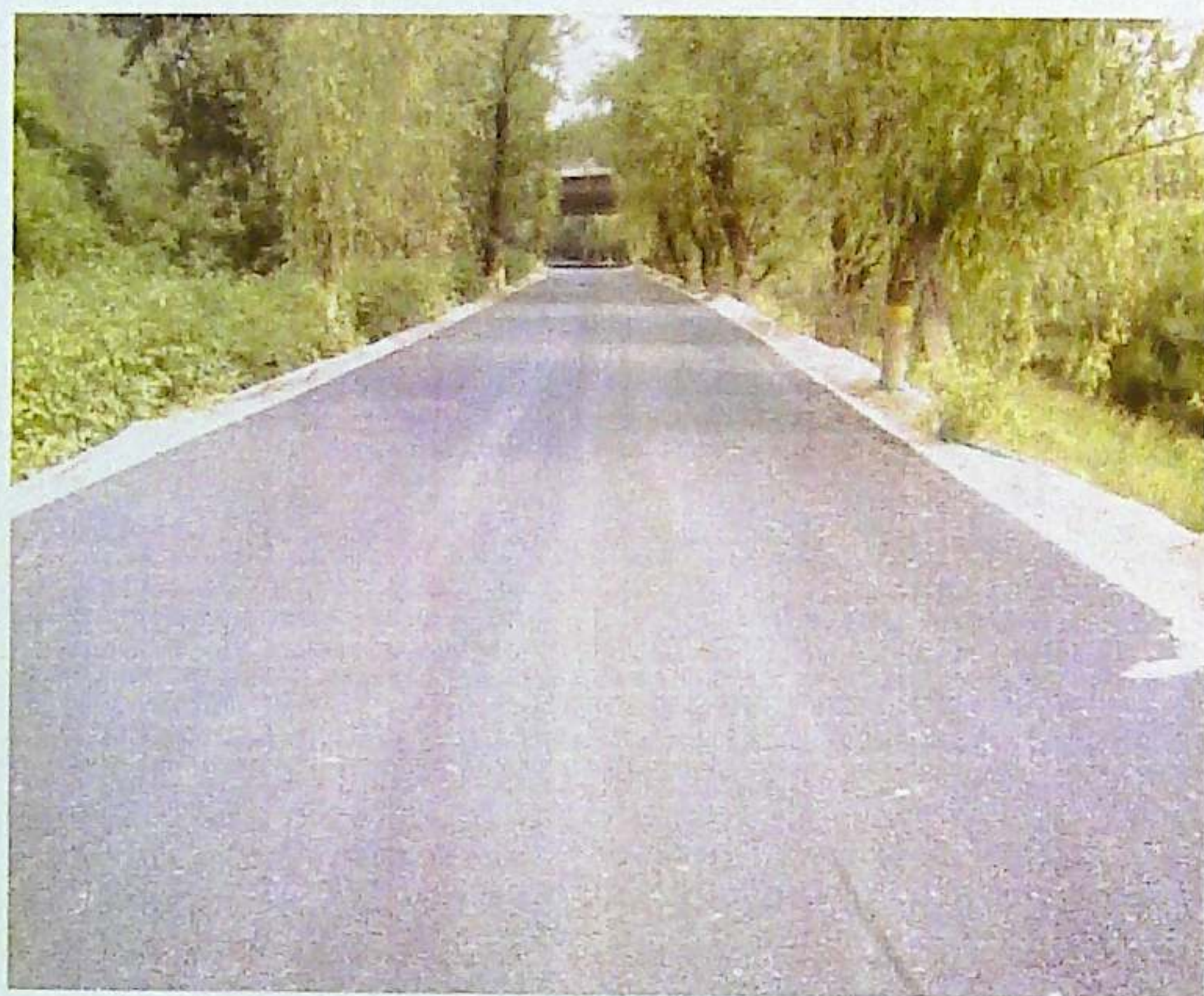
神华泗路桥下游右岸堤路修复完工效果
