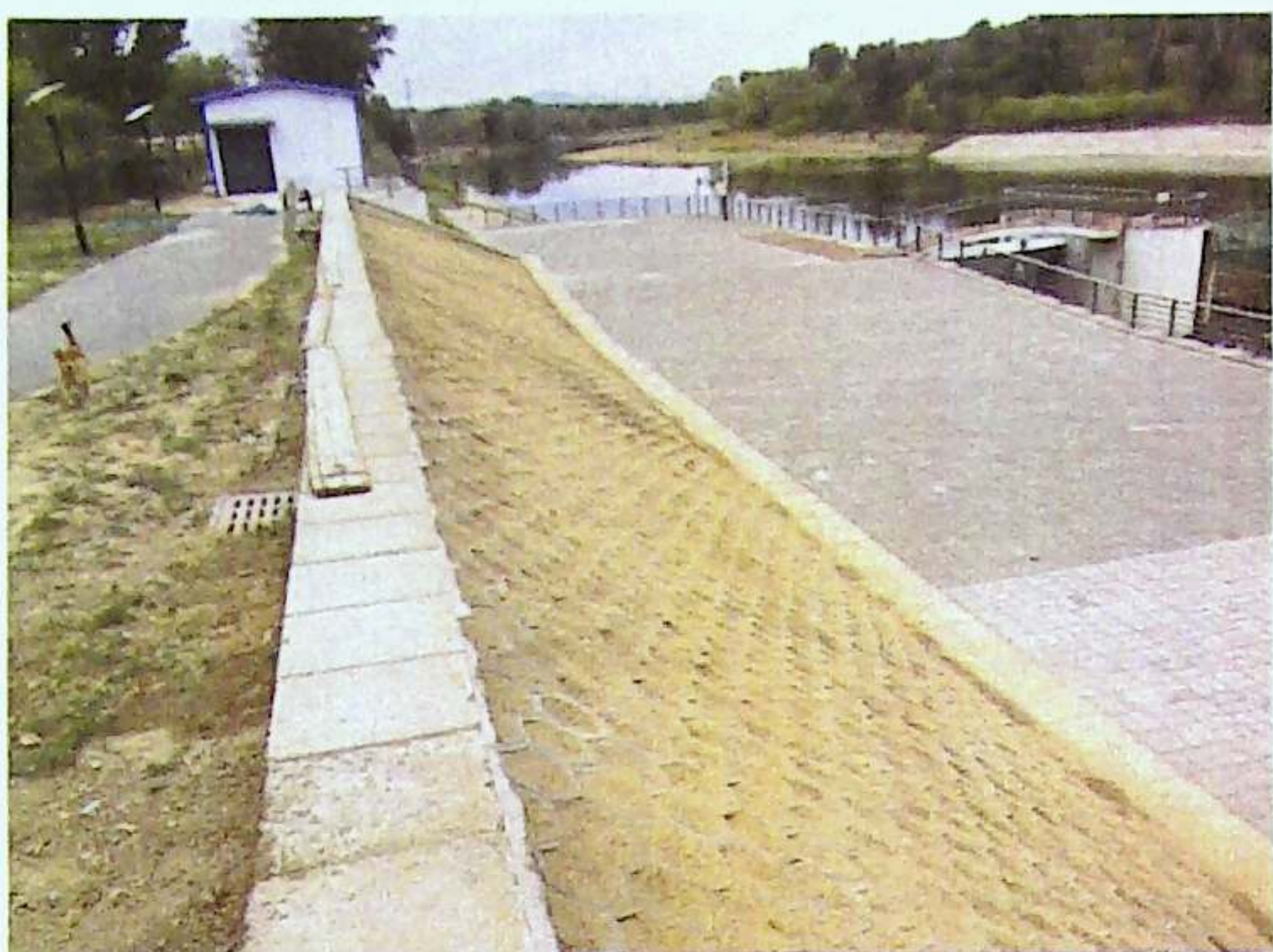
清除破损的实心六棱砖护岸，改为空心六棱砖 修复鲁疃闸破损的浆砌石护坡
