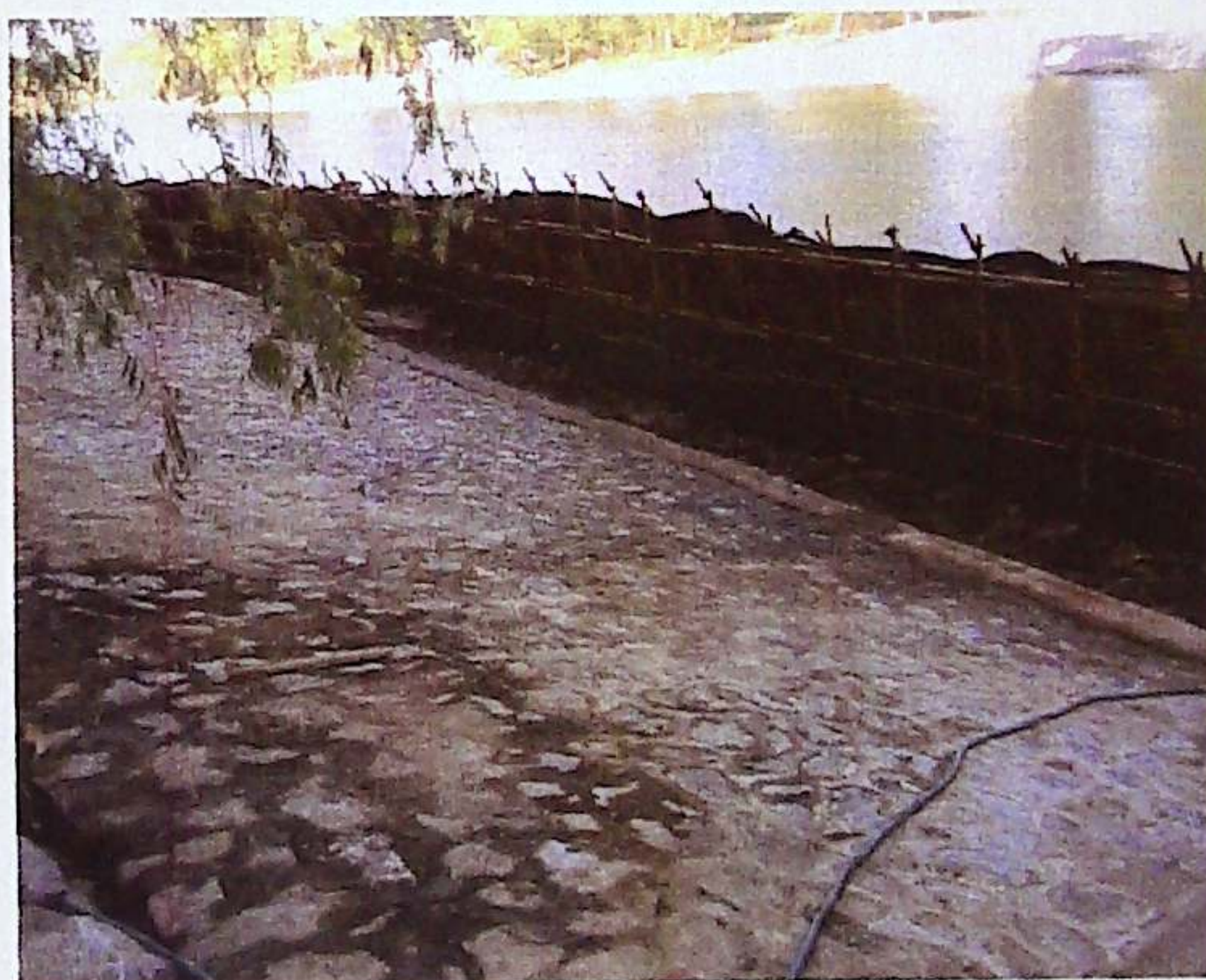
鲁疃闸浆砌石护坡修建完成效果
