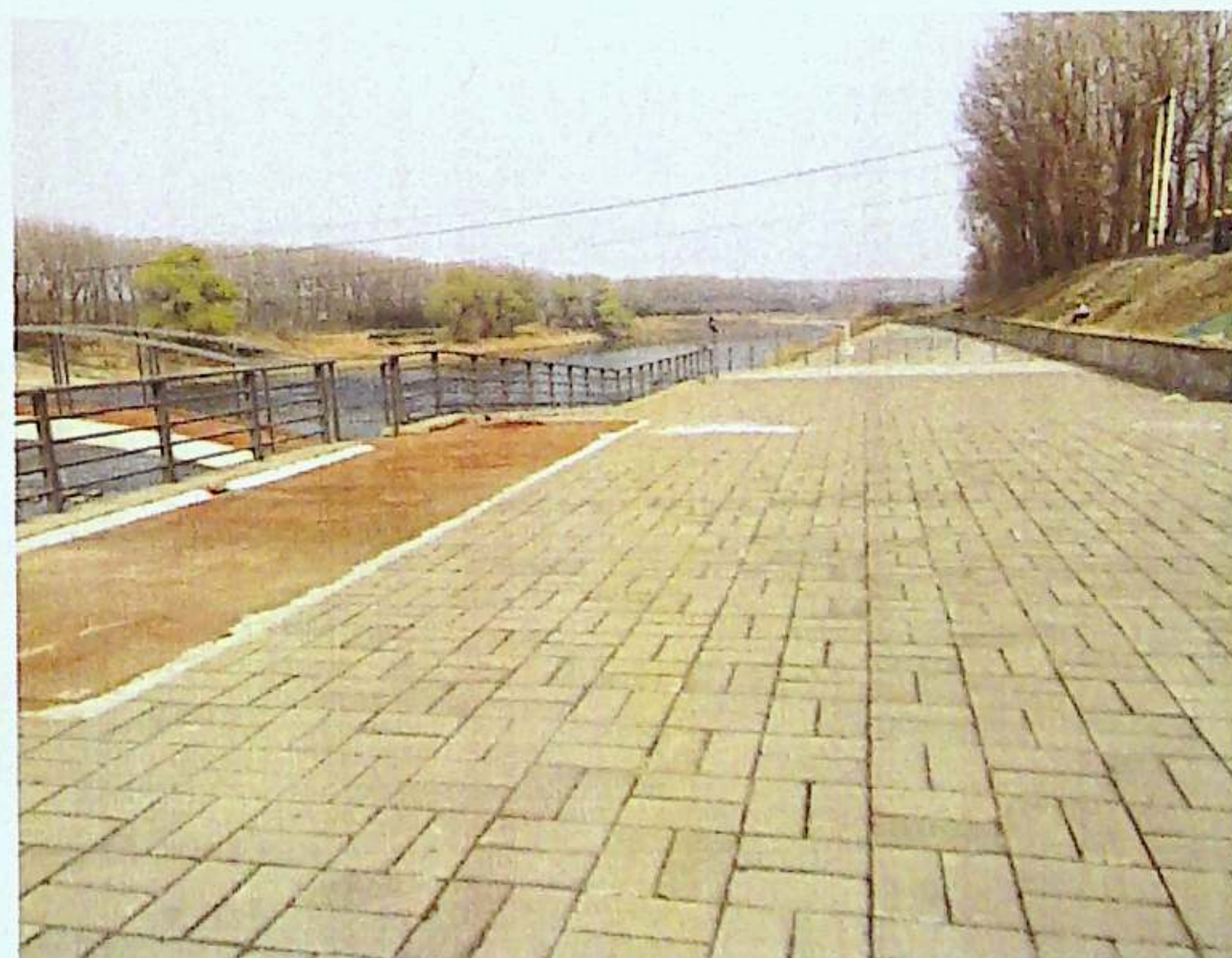
项目桥梁平台现状情况
