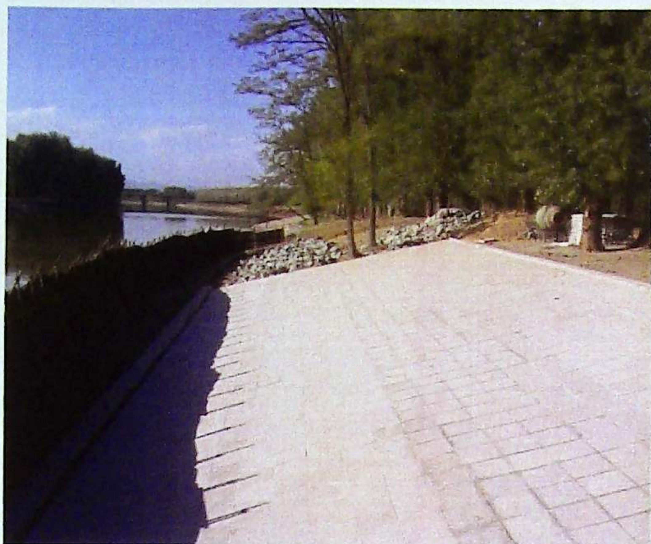
鲁疃闸混凝土大方砖护坡完成效果
