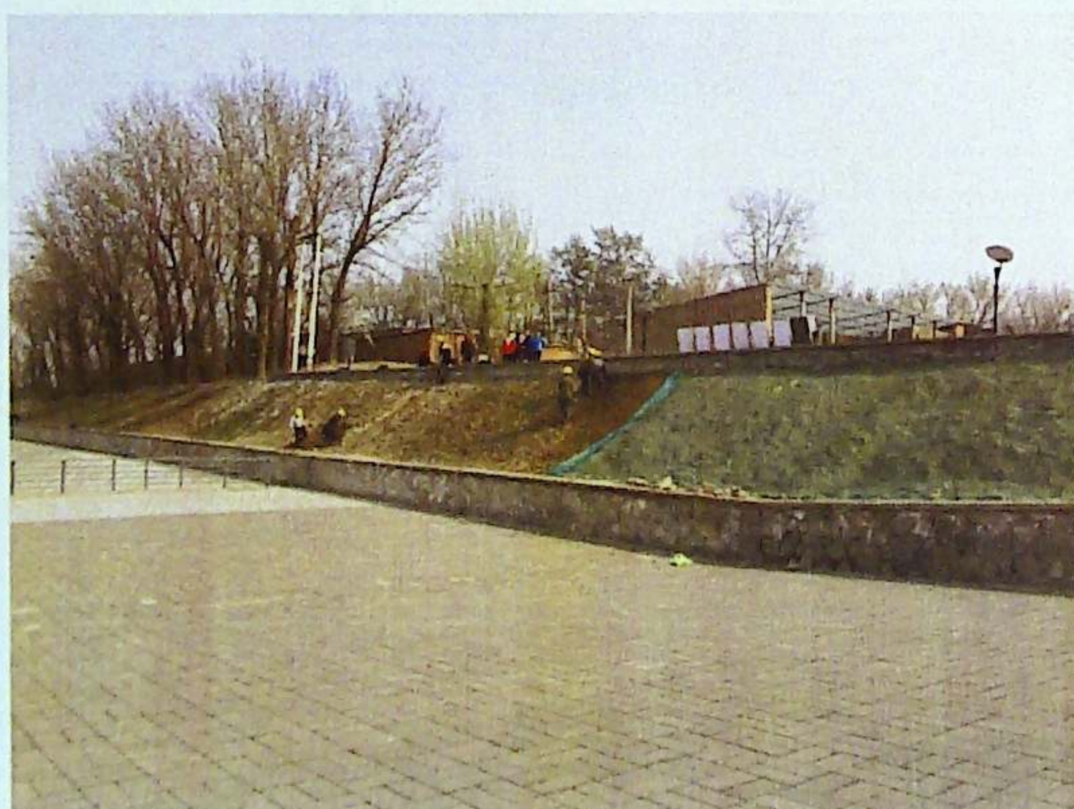
项目施工现场周边环境保护状况较好，未发现土块洒落情况
