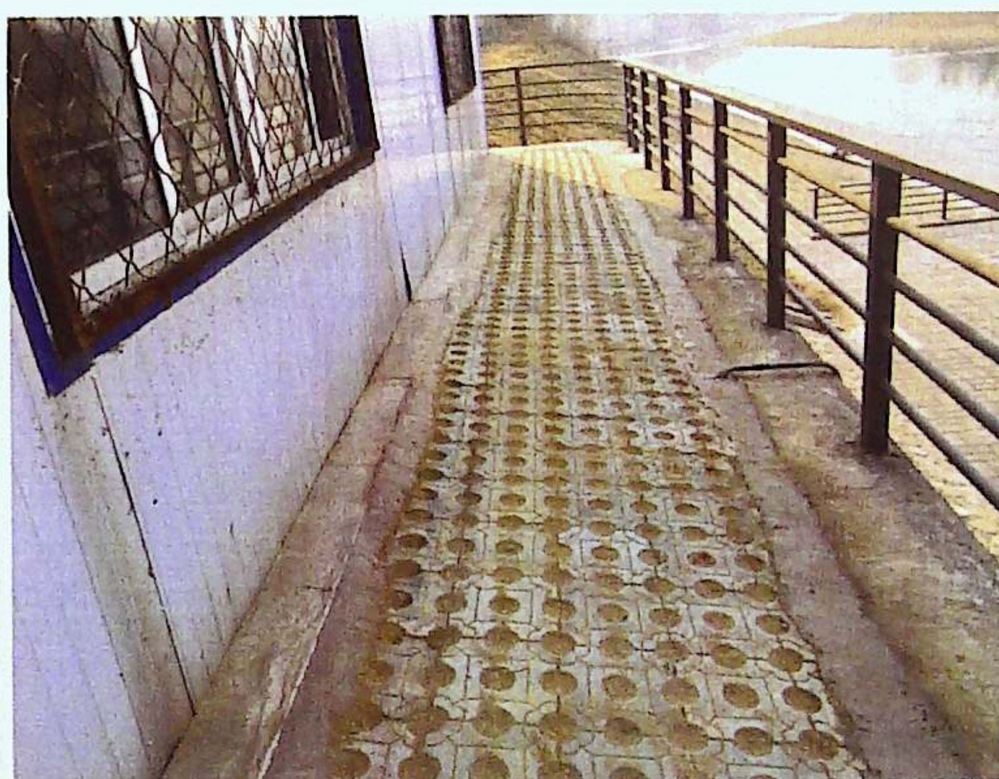
对液压站室外地面破损进行修复
