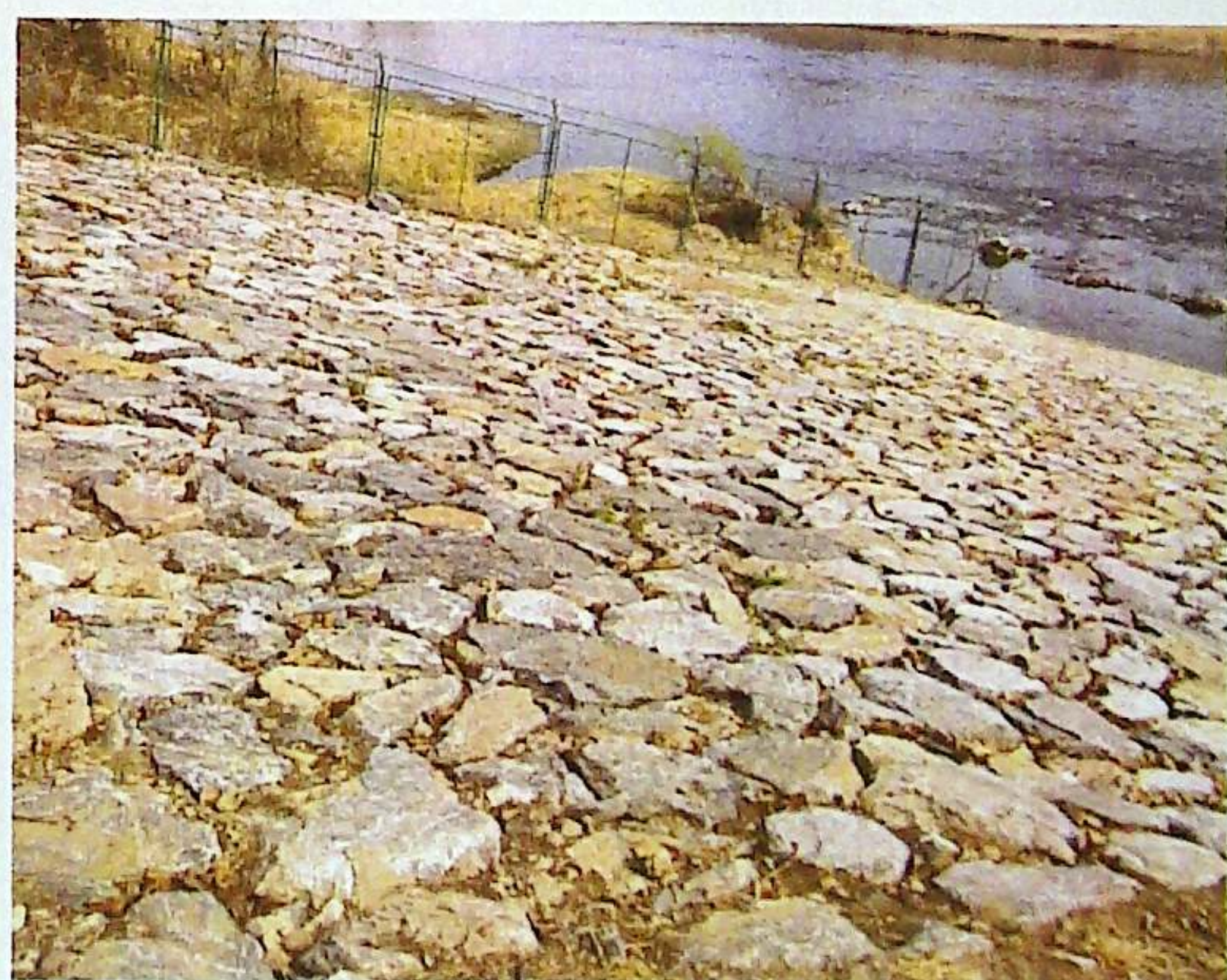
浆砌石护坡修复及围网修复整体完成效果
