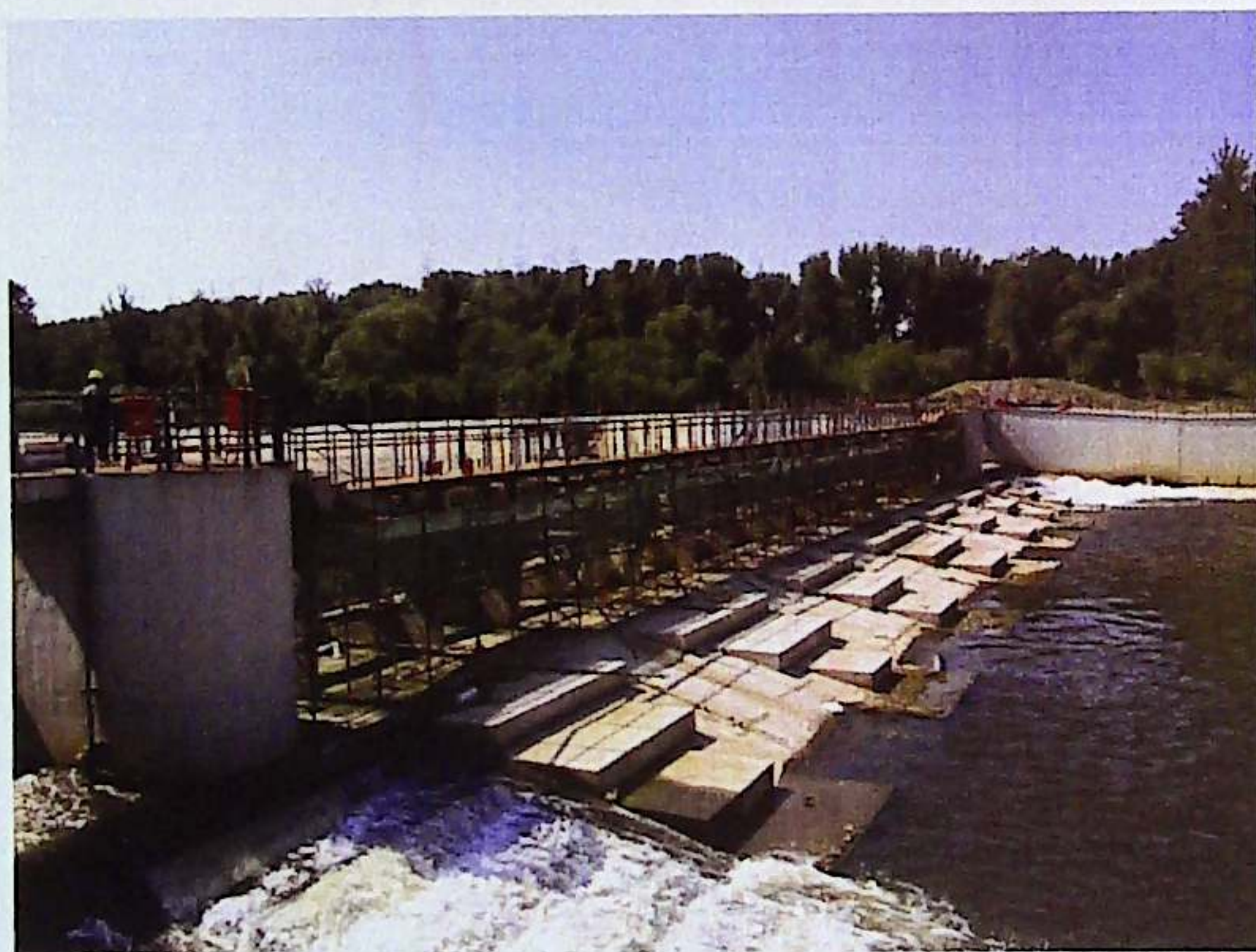
辛堡闸工作桥修建完毕，拆除施工材料
