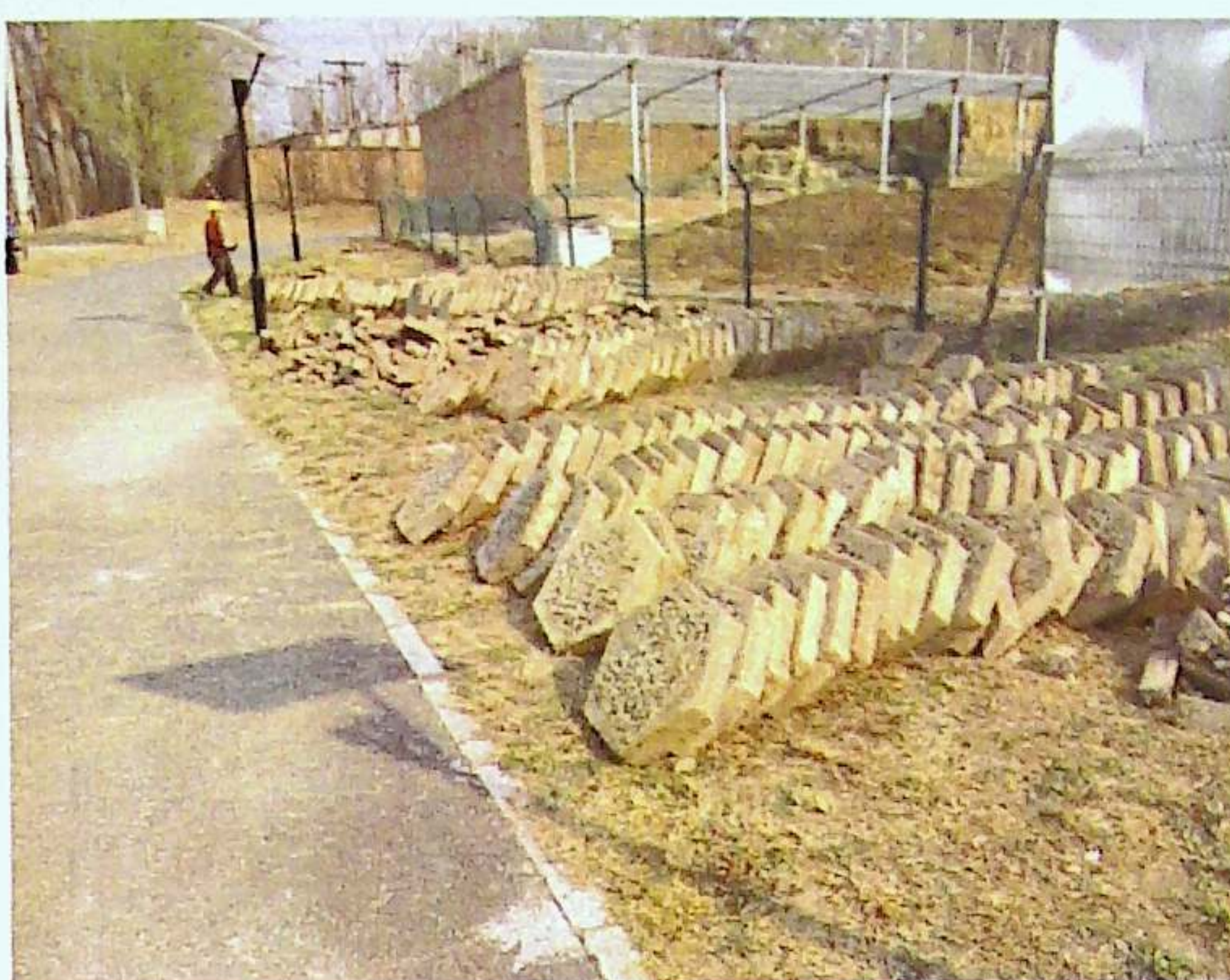
完好实心六棱砖及损坏的实心六棱砖分类堆放
