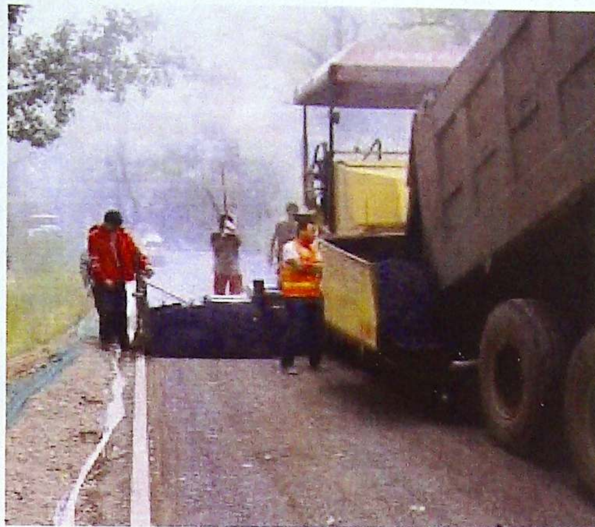
神华泗路桥下游右岸堤路修复施工现场
