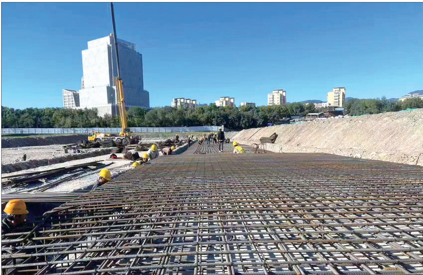
工人们在门城湖1号连通桥进行基础钢筋绑扎。
