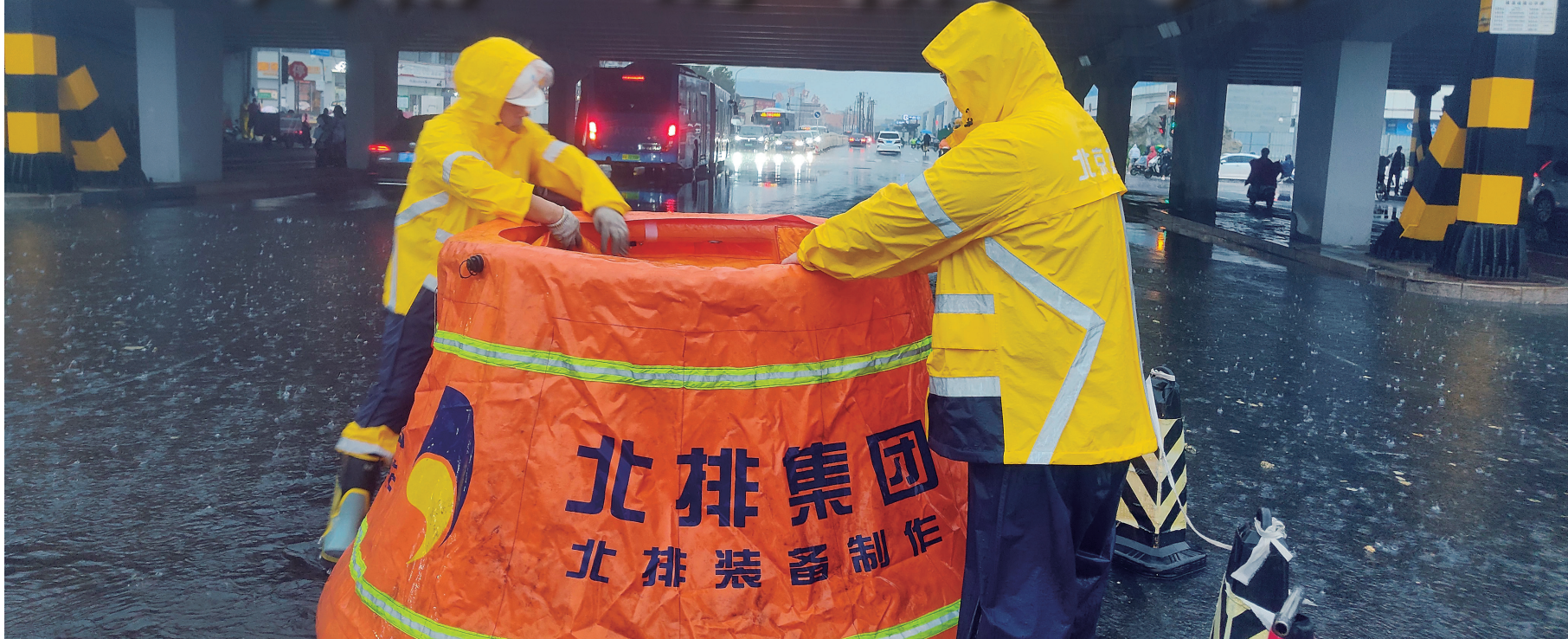
北京排水集团第二管网分公司防汛保障人员在十里河桥安装防溢桶。
